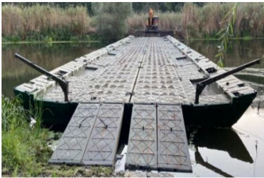
Рис. 1 – Переправа через річку, яка налаштована з майна ПМП [2]
