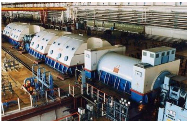
Рисунок 1 – Общий вид турбины K-500-65/3000, вид со стороны генератора
