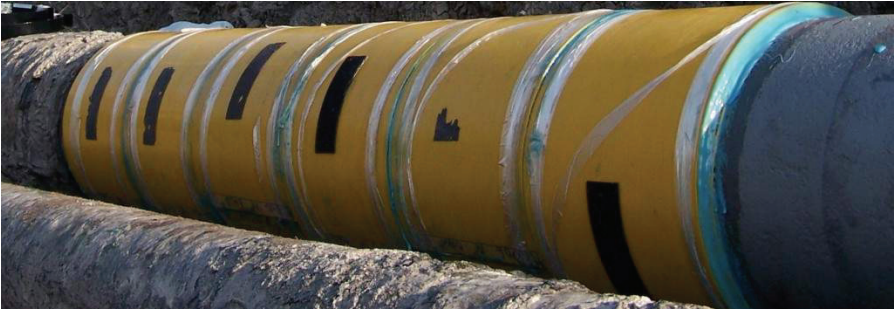
Рисунок 1 – Композитна ремонтна накладка, нанесена на трубопровід
